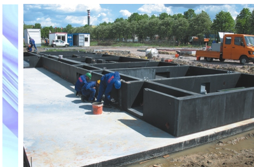
Posadowienie segmentów fundamentów na płycie żelbetowej
