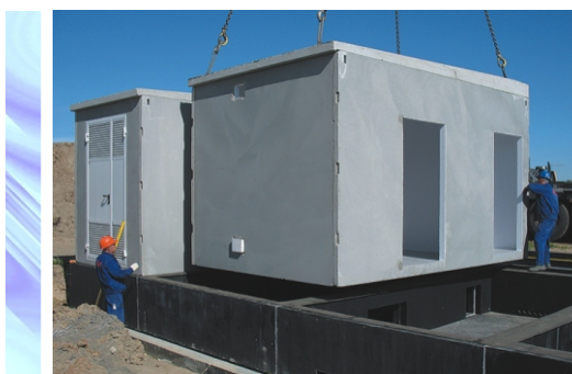
Montaż segmentów i ścian obudowy
