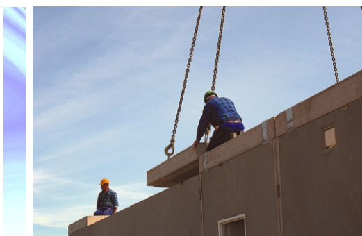
Pokrycie stacji segmentami dachowymi
